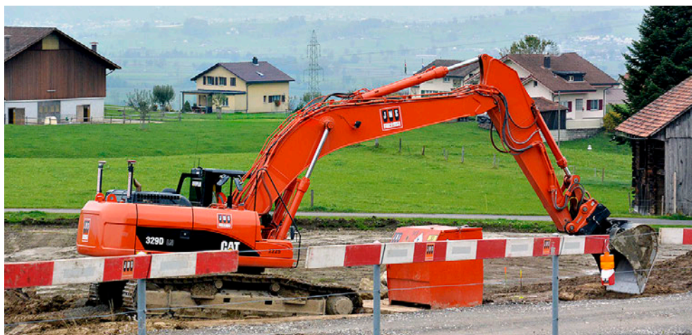
O sol nem sempre brilha nos estaleiros de obras suíços. Em caso de condições meteorológicas adversas e temperaturas frias, o trabalho pode ser interrompido. Foto: Colette Kalt
